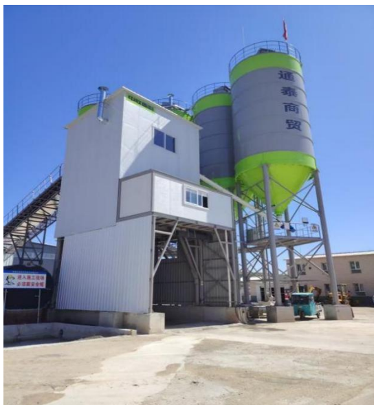
图 3-3 全封闭搅拌塔楼
