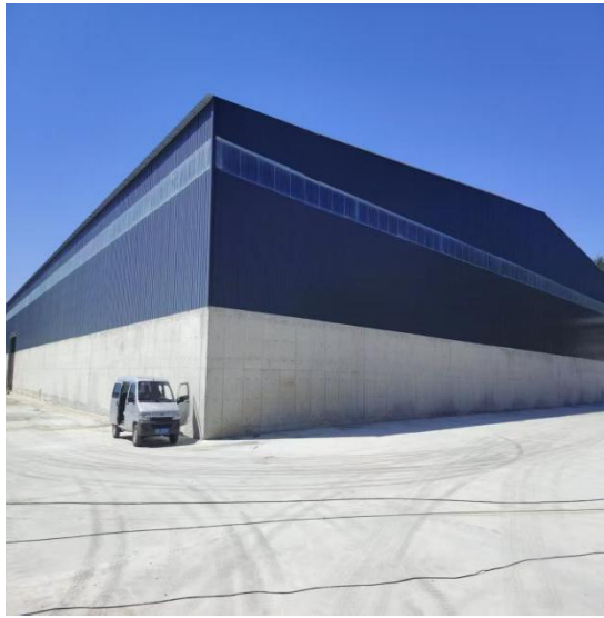
图 3-1 封闭式原料棚
